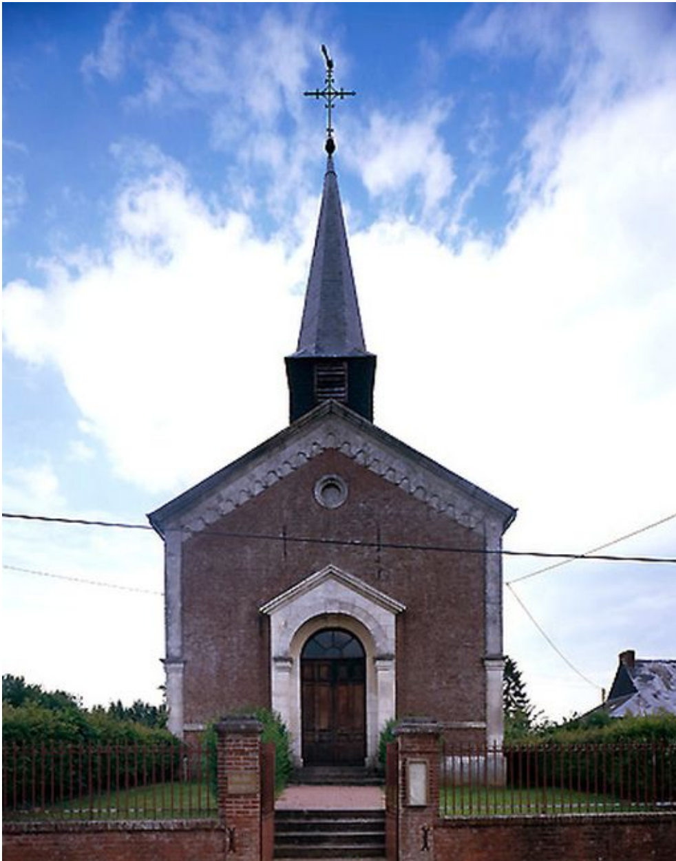
Vue générale de la façade occidentale.
