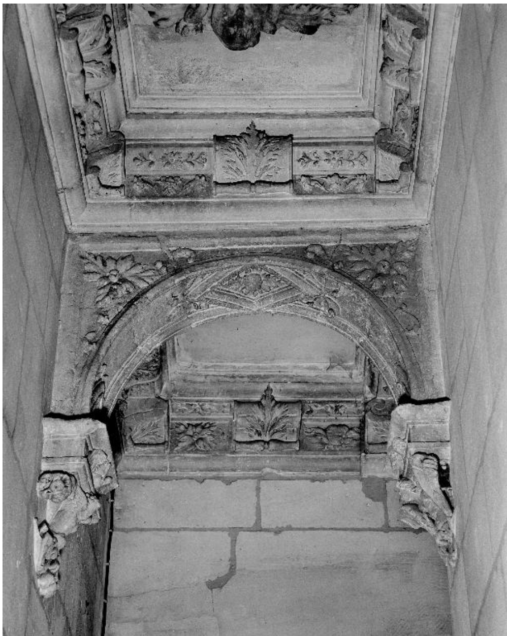
Vue d'un arc diaphragme.
