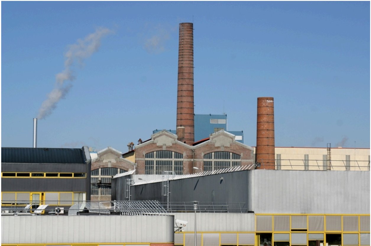
Aperçu des trois halles des années 1920.
