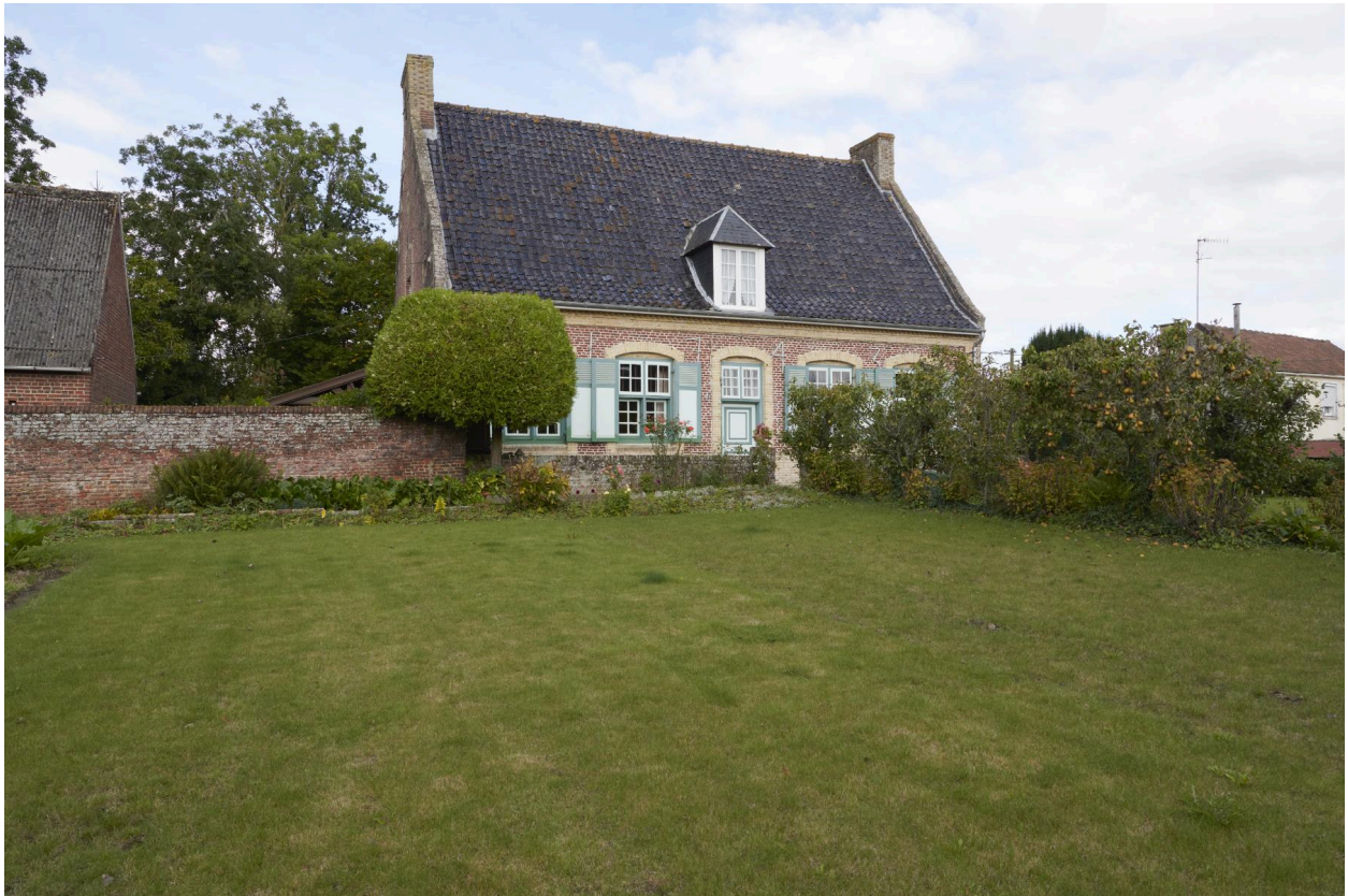
Vue de la façade sud.
