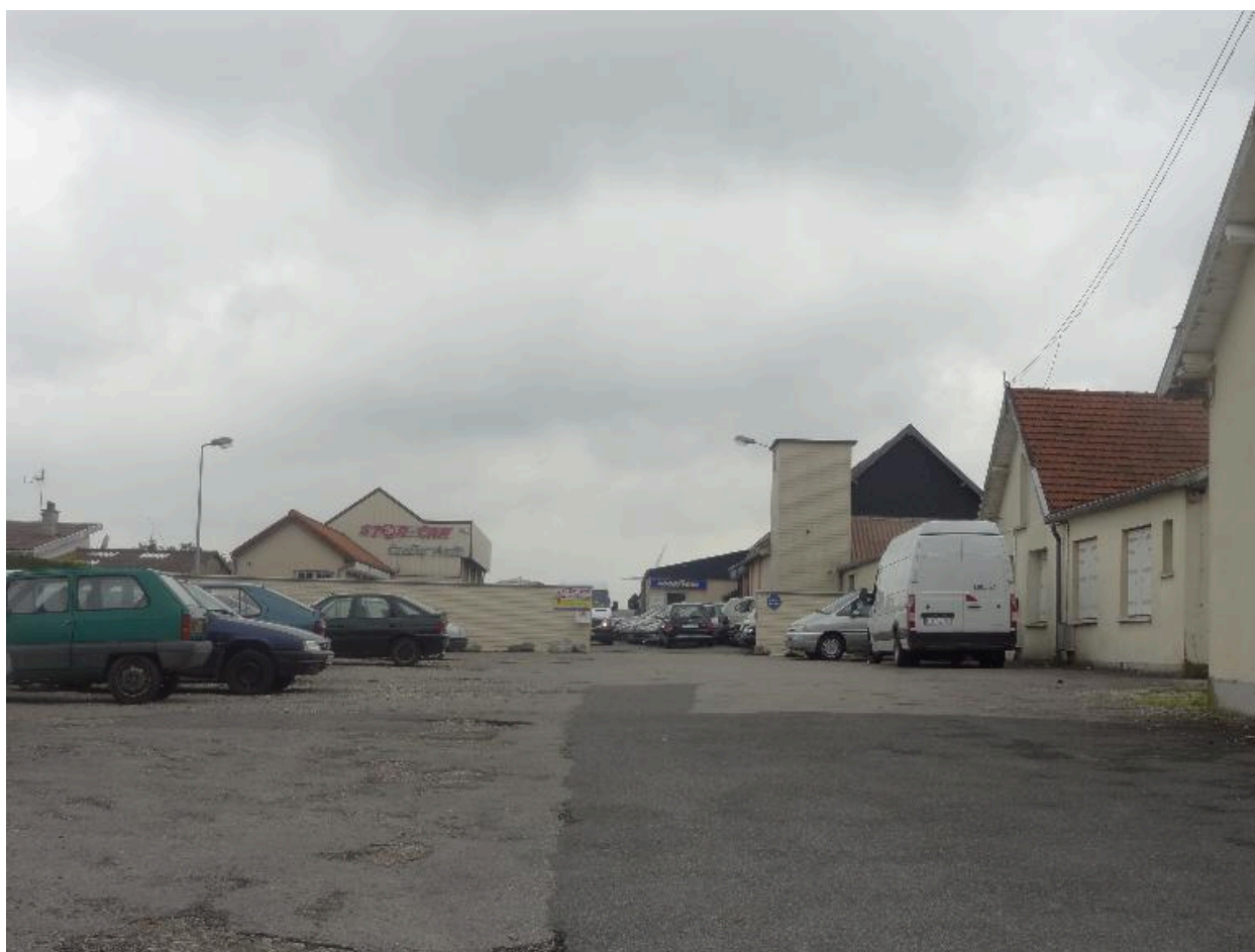
Vue générale depuis la rue du Générale Leclerc.
