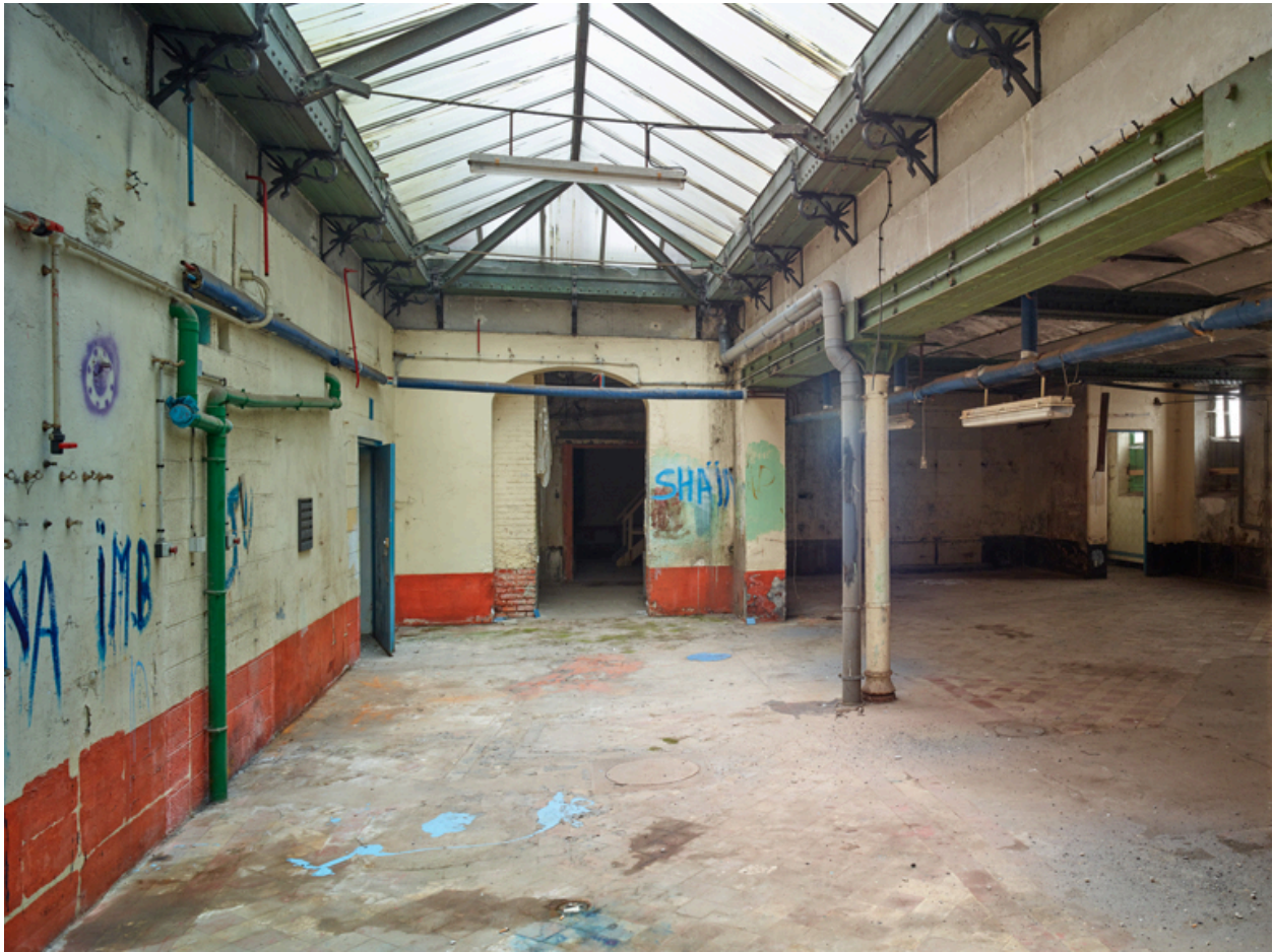
Aile nord, sous-sol. Vue générale du lavoir vers le nord. Cour couverte d'une charpente métallique vitrée.
