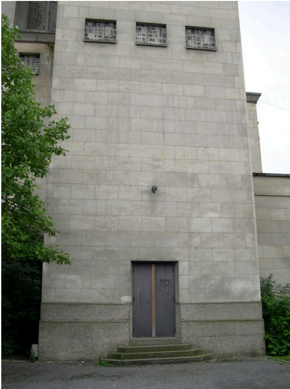
Vue de détail : base de la tour.
