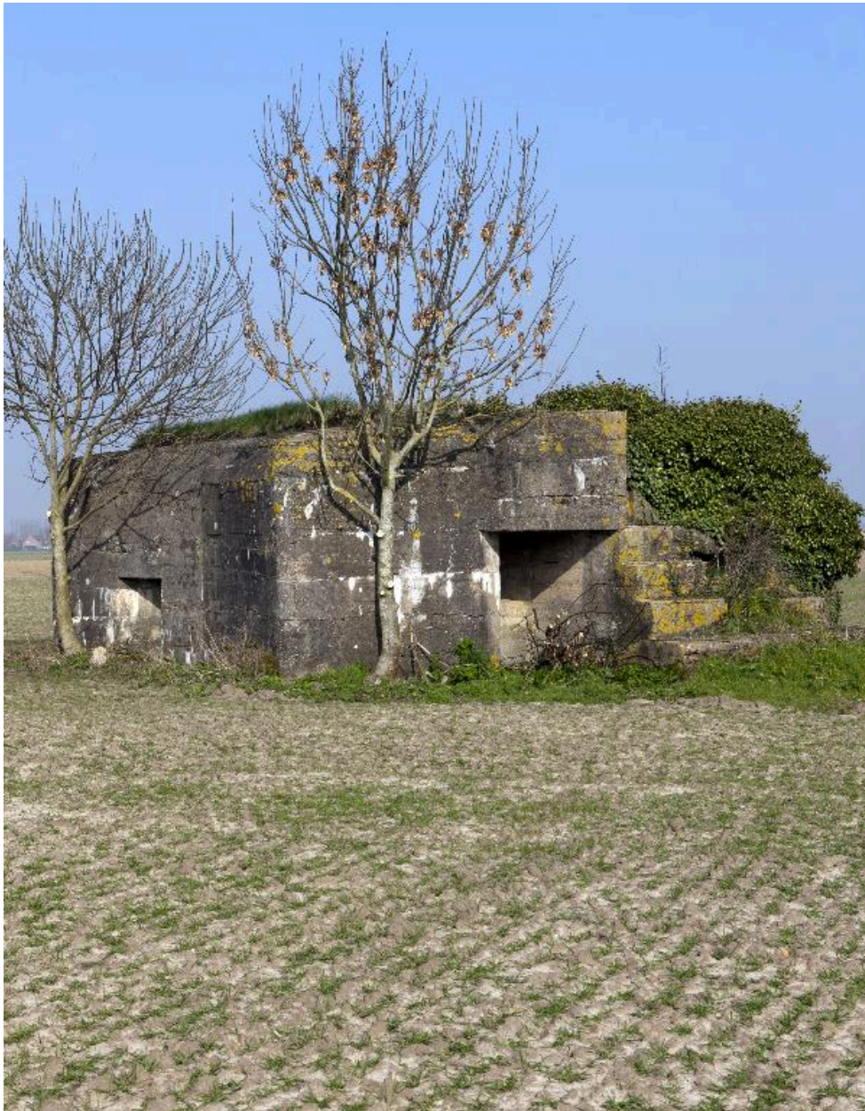
Vue générale vers le nord-est
