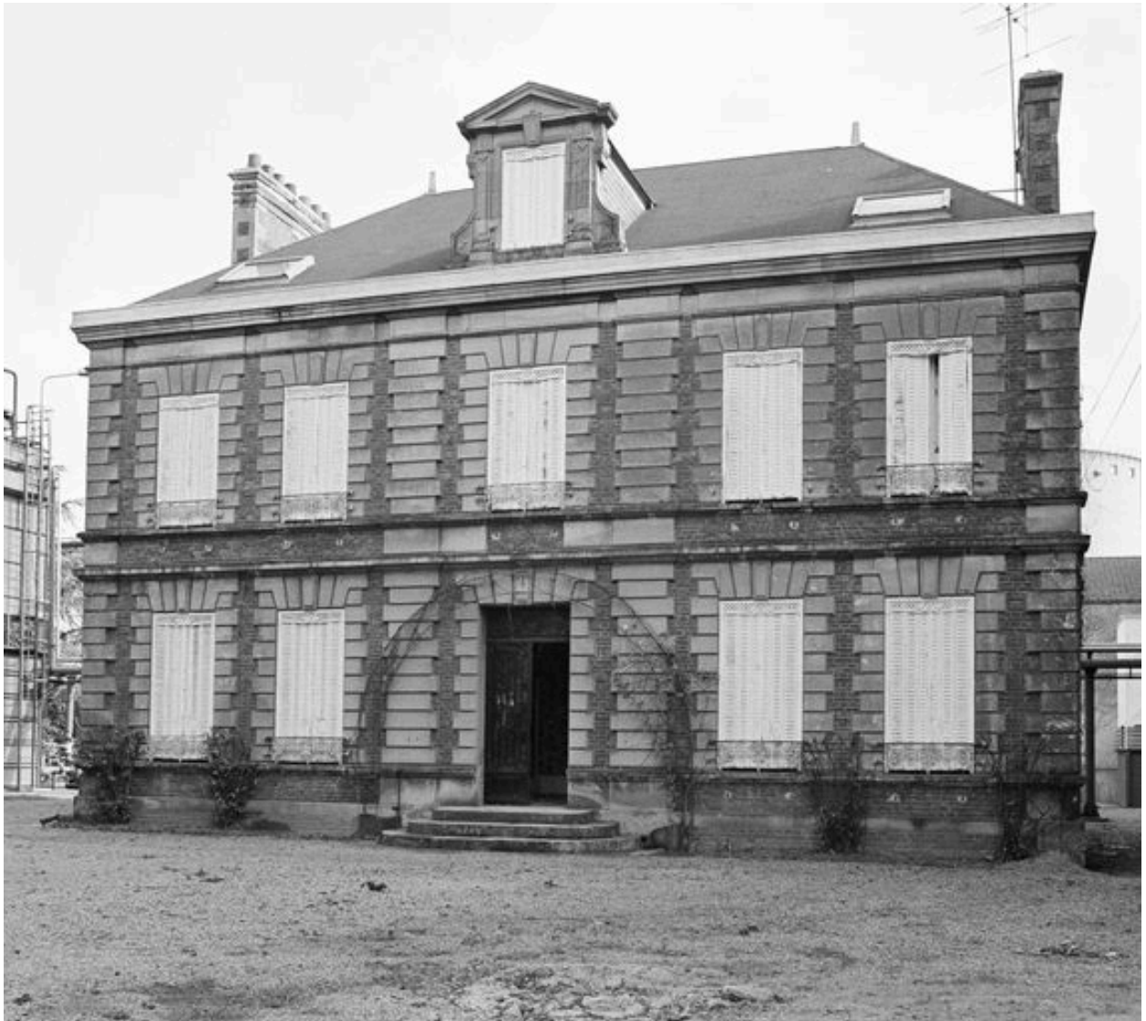
Logement patronal : élévation antérieure.
