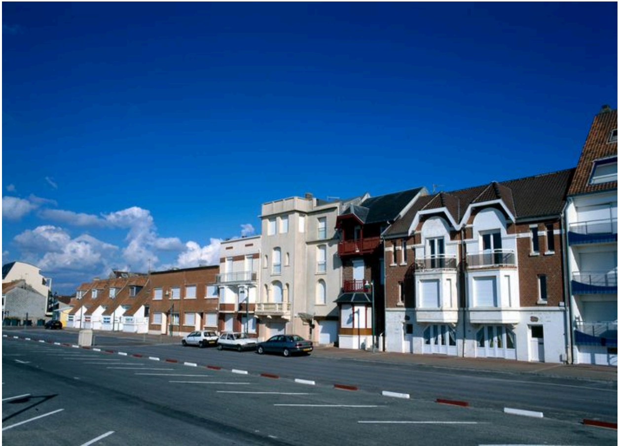
Les constructions de la digue sud.
