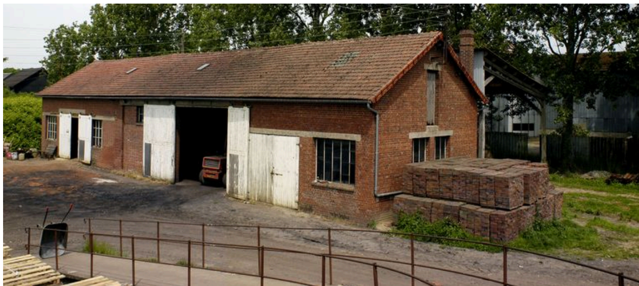
L'atelier de mécanique et l'entrepôt à charbon.
