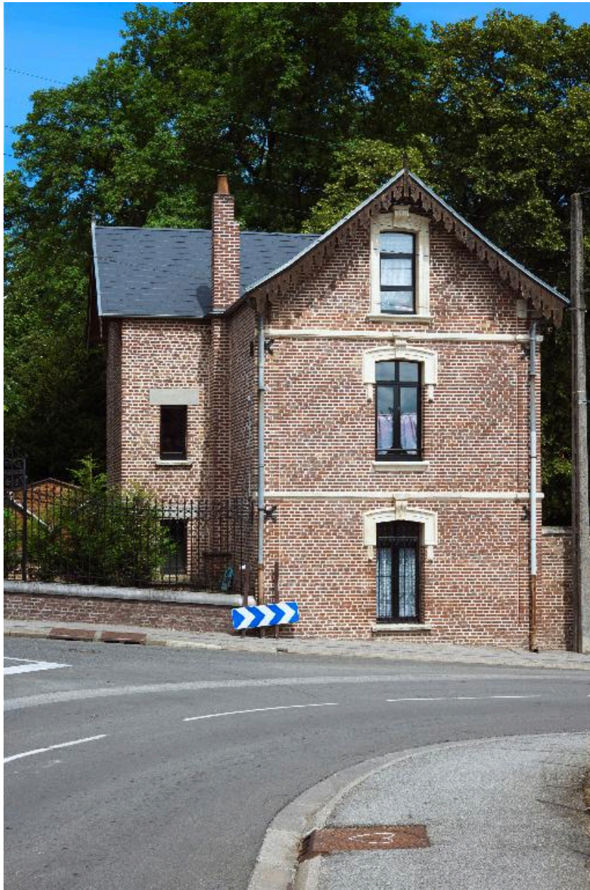
Façade pignon sur rue du logement de gardien.
