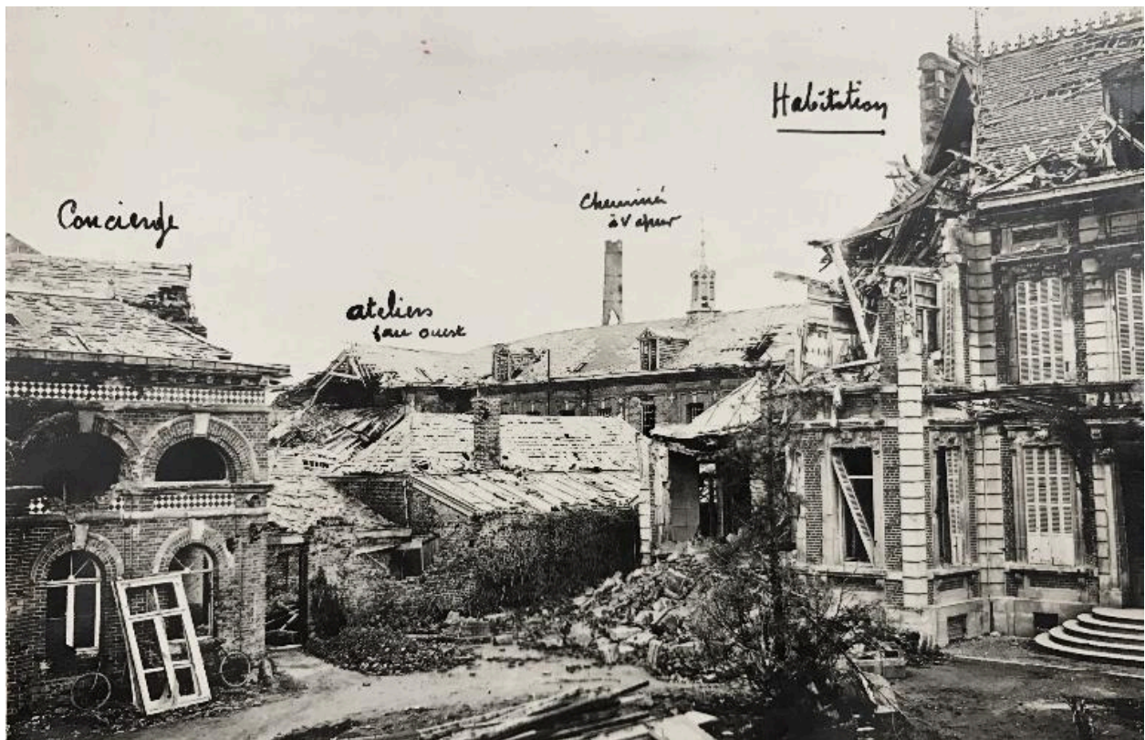
Etat des destructions de l'habitation et de la conciergerie, vue vers l'ouest (AD Somme ; 10 R 1276).
