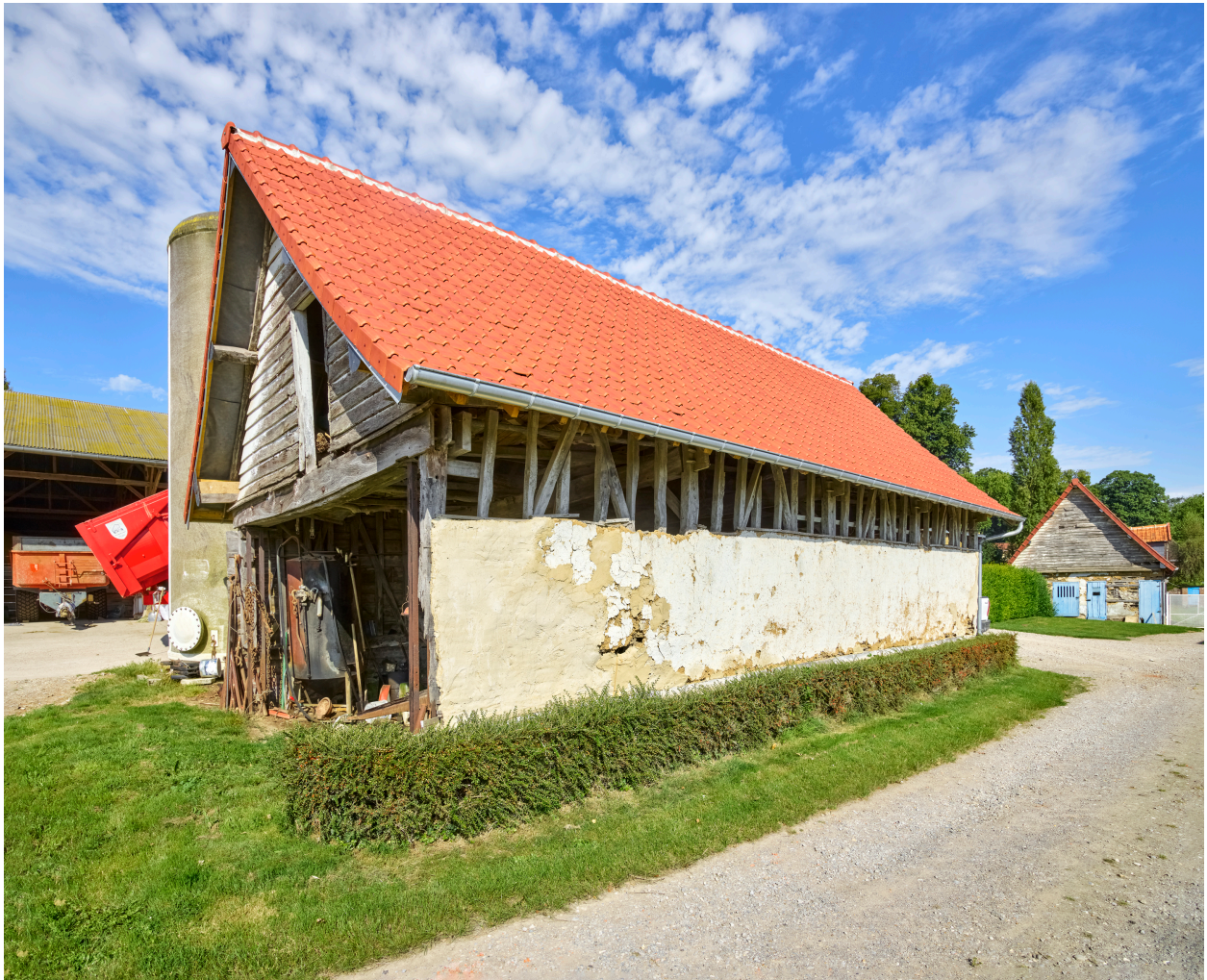
Vue de la charreterie, depuis le sud-est.
