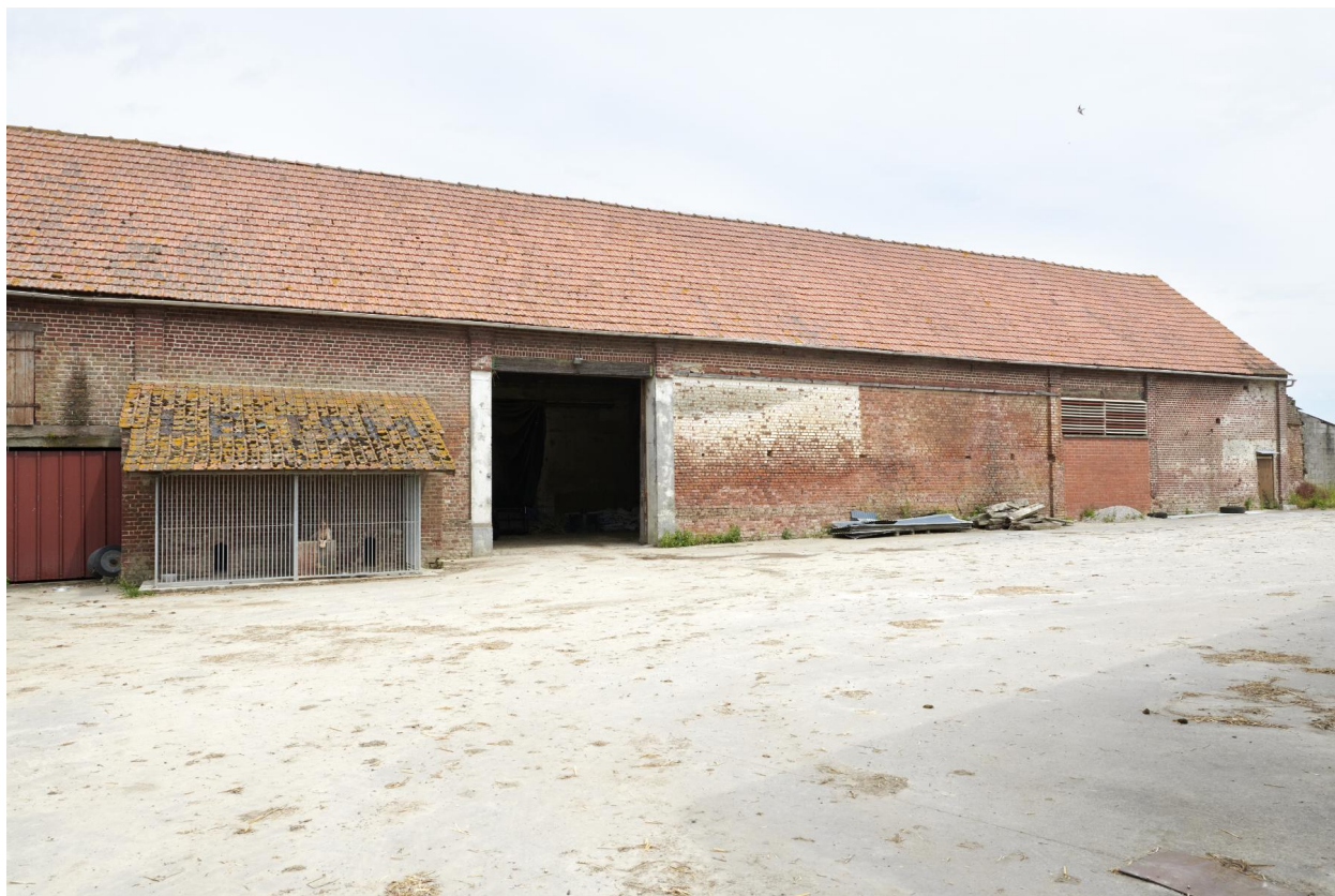
Bâtiment au nord de la ferme.
