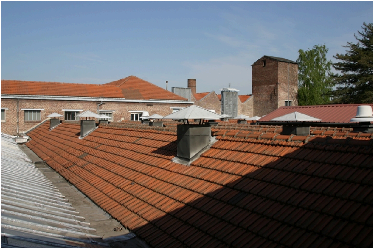
Vue des toitures des ateliers.
