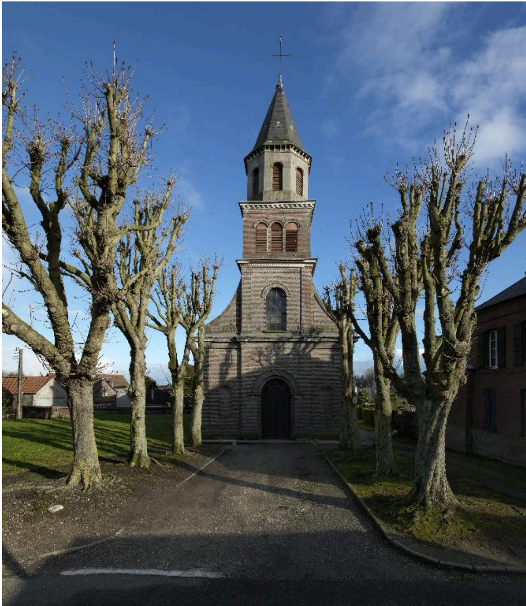
Vue depuis le nord.
