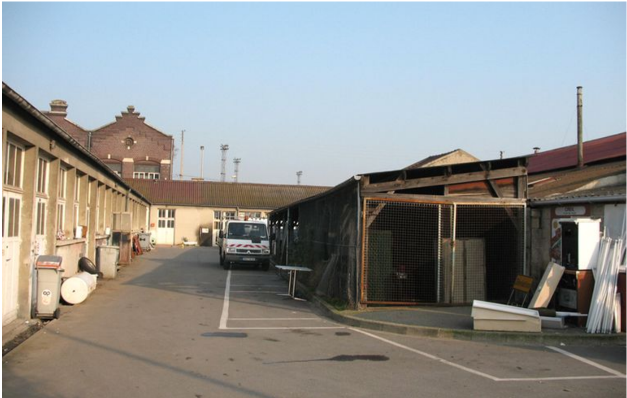
Vue générale des ateliers municipaux.
