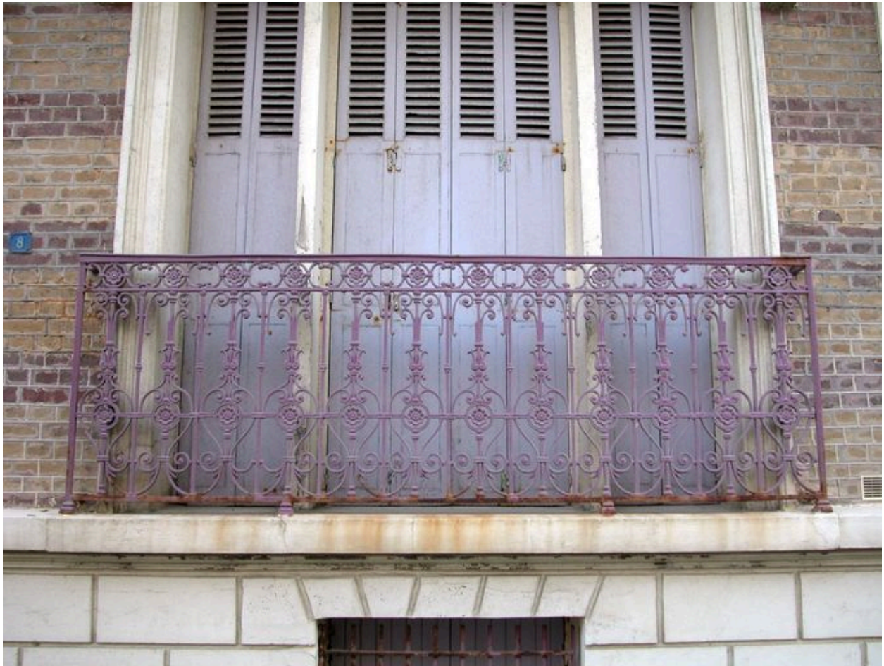
Détail du décor de fonte du garde-corps de balconnet de l'habitation dite Heures Claires (partie gauche de la maison).
