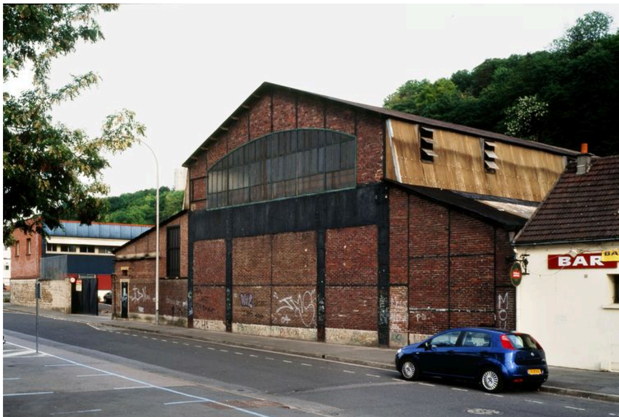
L'atelier construit en 1926 rue Michelet.
