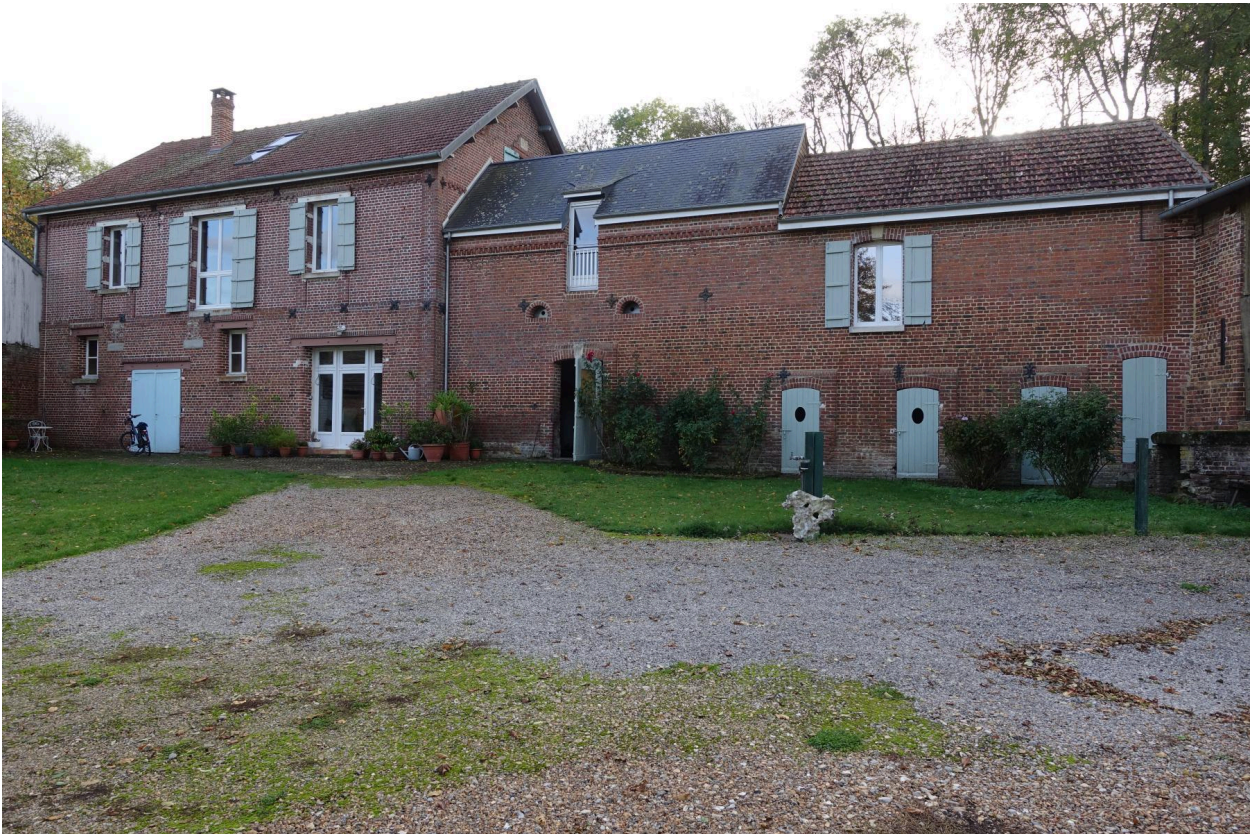
Ancienne grange et bâtiments d'élevage.
