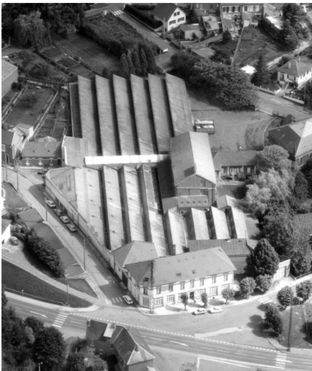
Vue aérienne, flanc nord-ouest.
