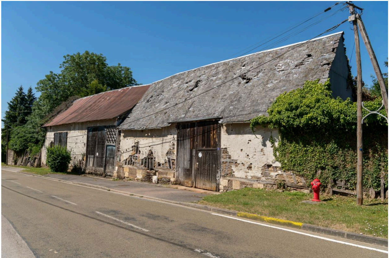
Anciennes granges sur rue, n°7-9 Rue Principale, vue depuis le sud-est.
