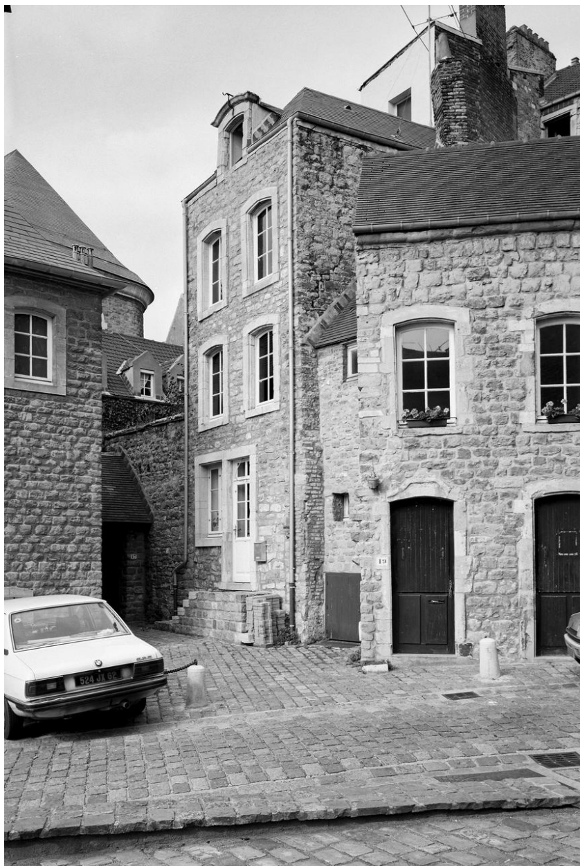
Angle sud-ouest après restauration.
