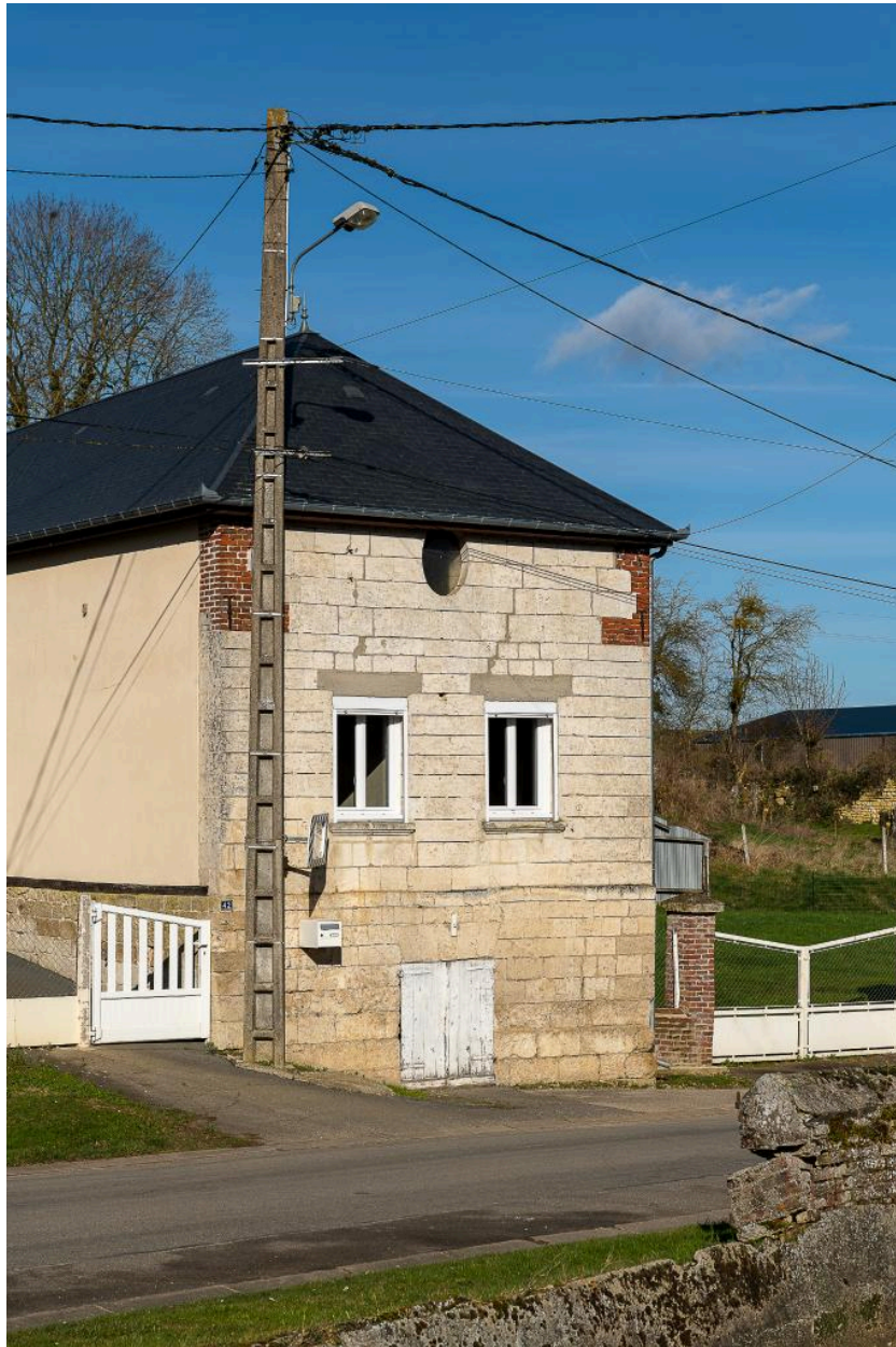
Vue depuis le sud du pignon en pierre du logis au n°42 Grande Rue.
