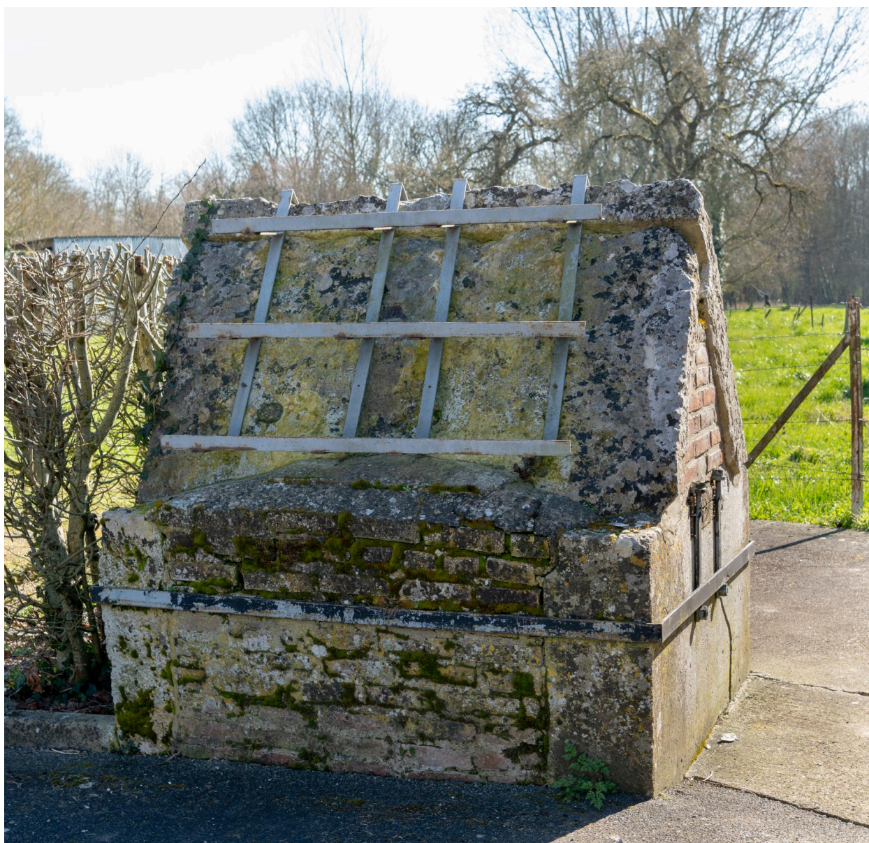
Ancien puits près de la mairie, vue depuis le nord.
