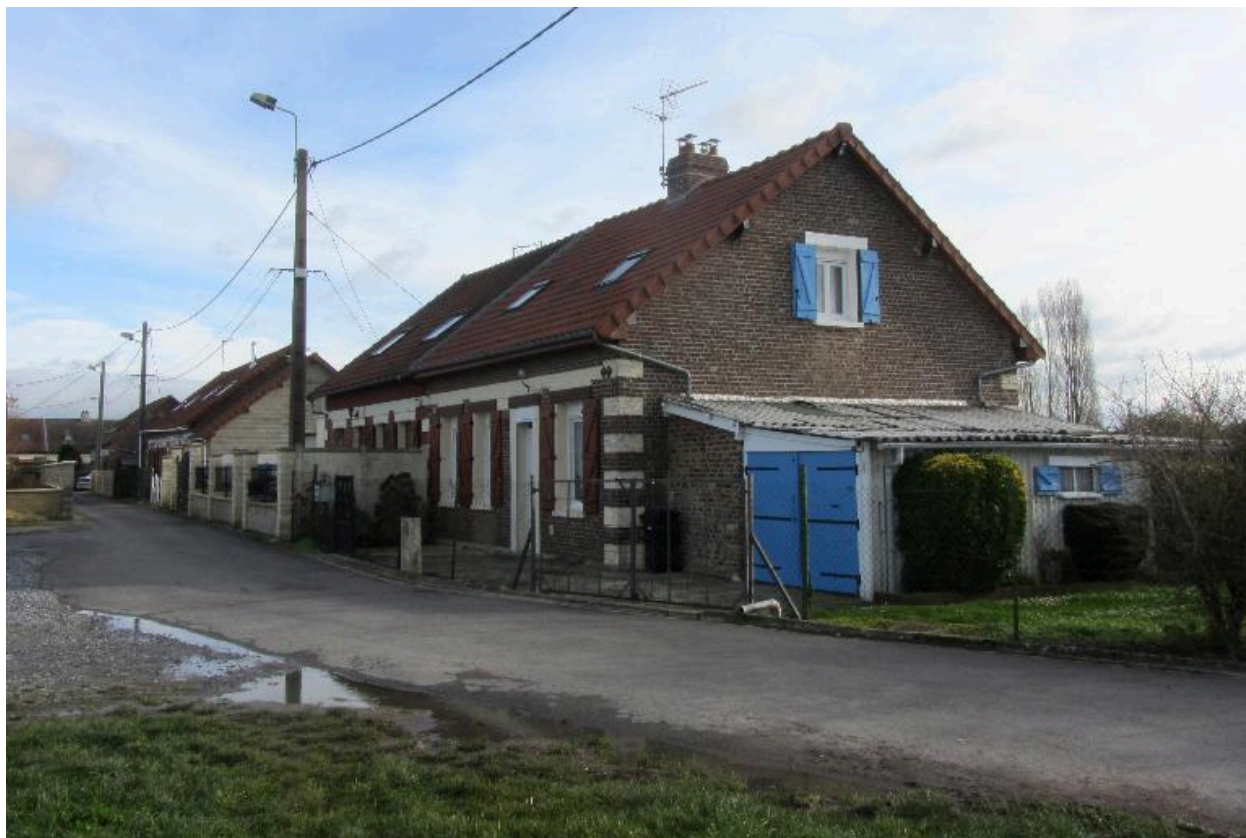
Maisons ouvrières de la cité Sébastopol, vue d'ensemble.
