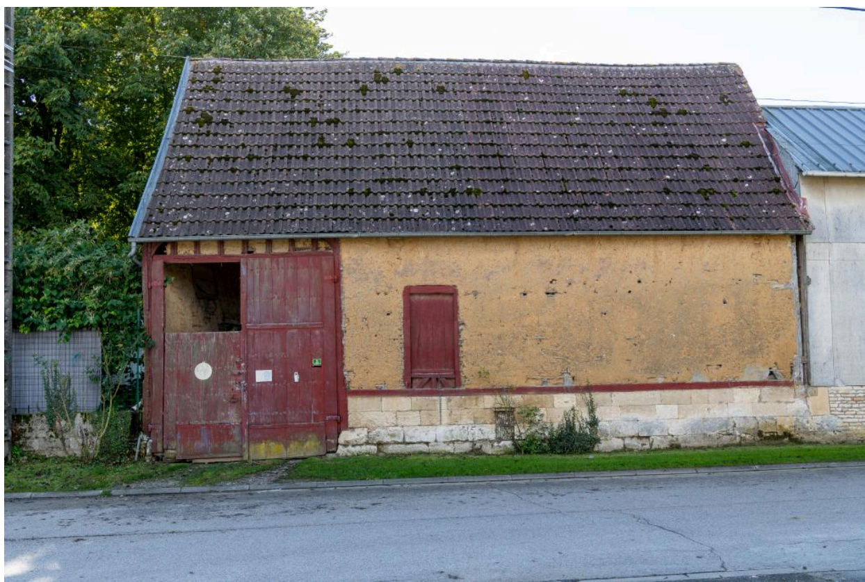
Ancienne grange, n°5 Grande Rue, vue depuis le nord.
