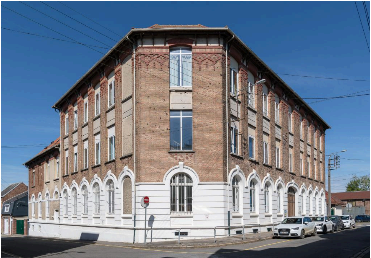
Vue générale de l'école depuis la rue Lecointe.
