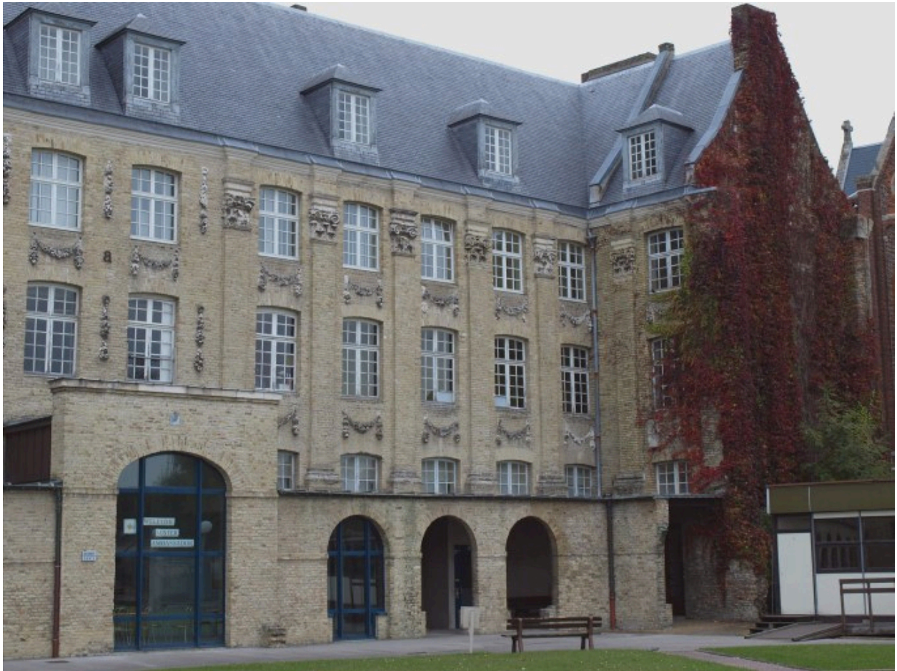
Détail (angle) de la façade sur cour du bâtiment de l'ancien collège des Jésuites anglais
