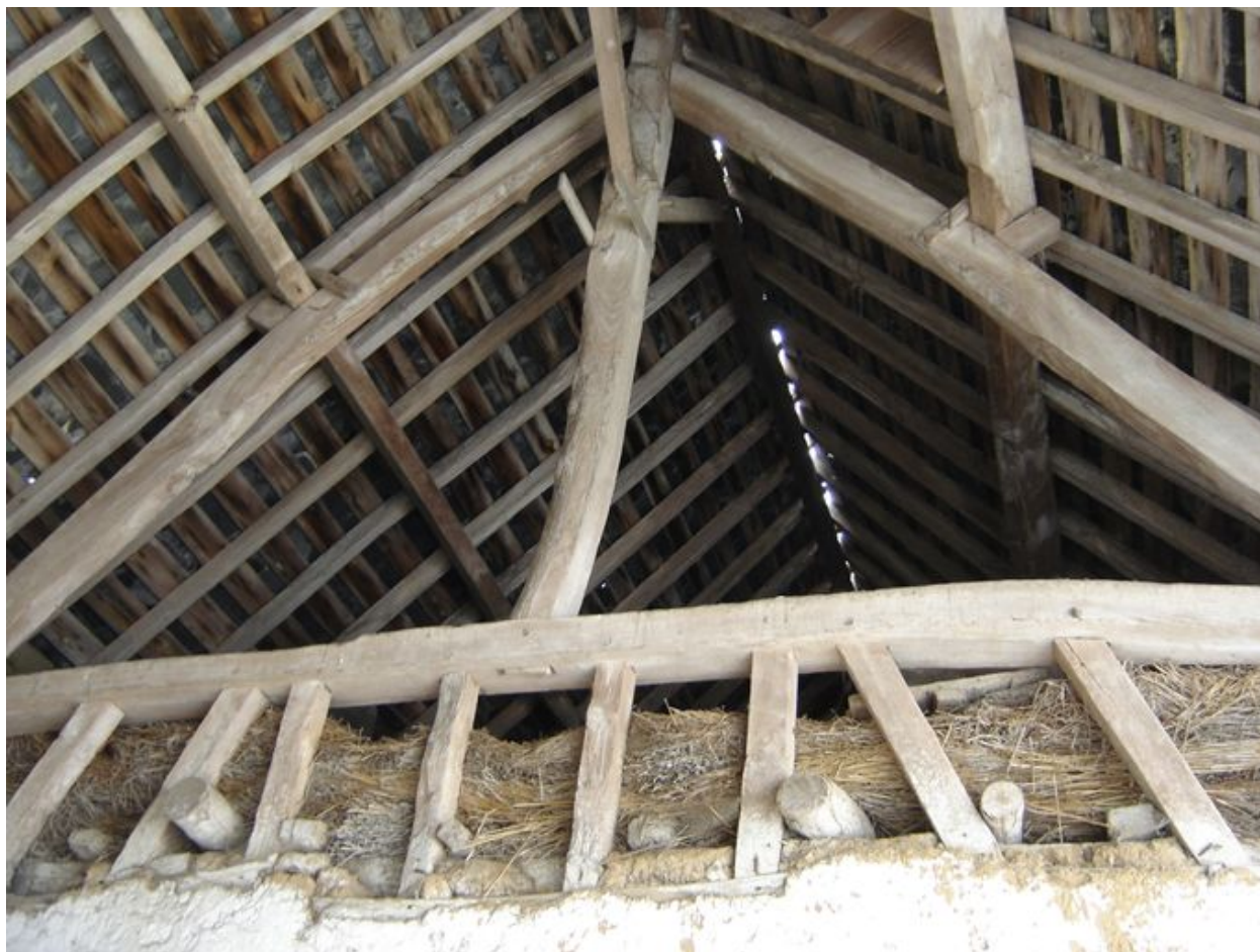
Détail de la charpente des étables.
