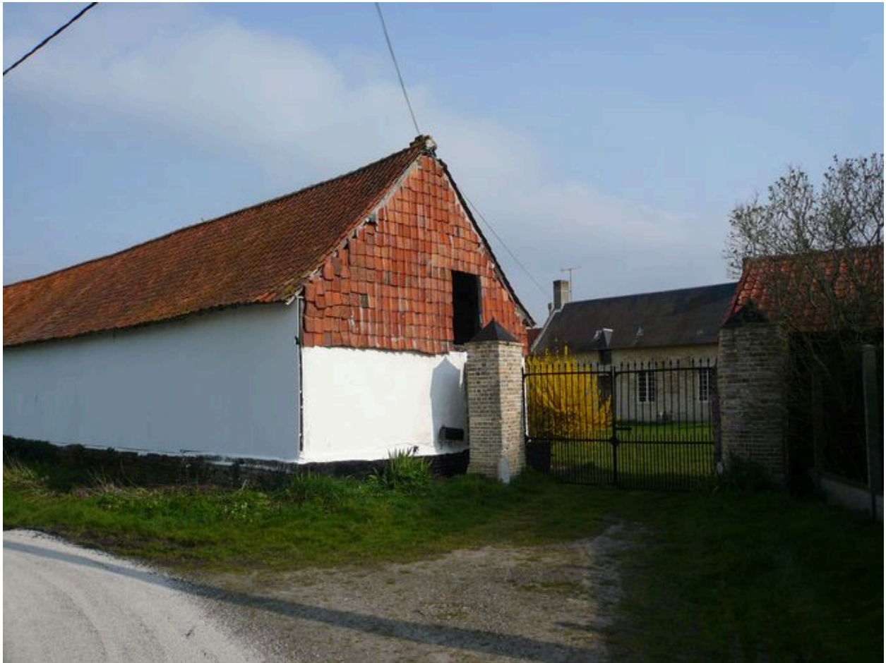
Vue de l'entrée depuis la rue.
