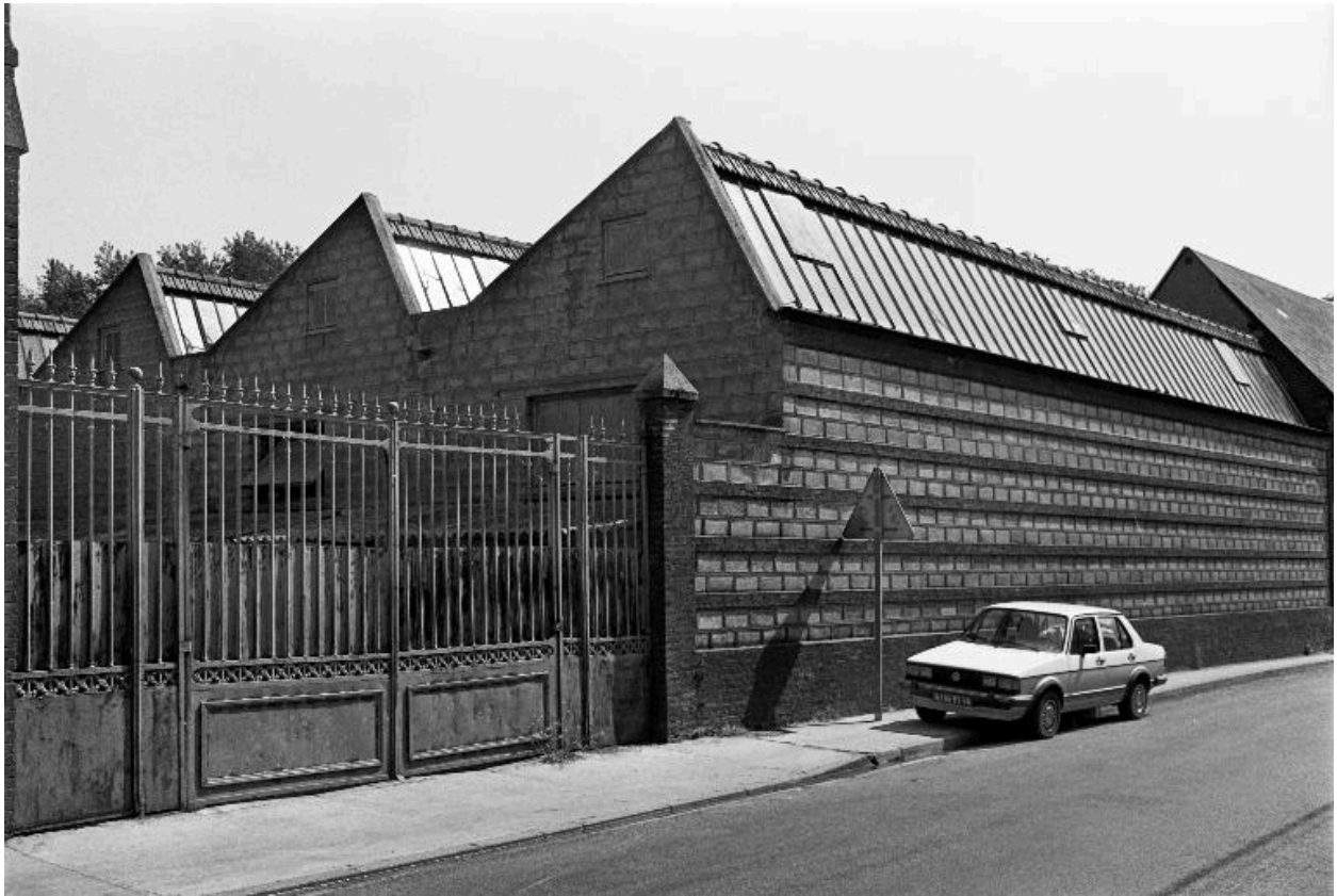
Atelier de fabrication, élévation antérieure, en 1990.
