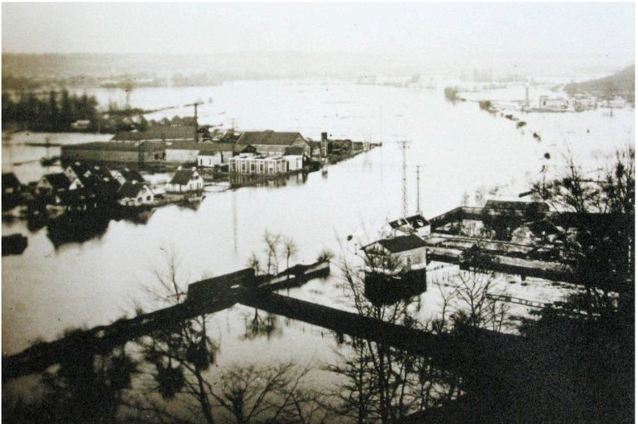
La tonnellerie sous les eaux de l'Oise lors de la crue de janvier 1926 (AC Nogent-sur-Oise ; fonds local).
