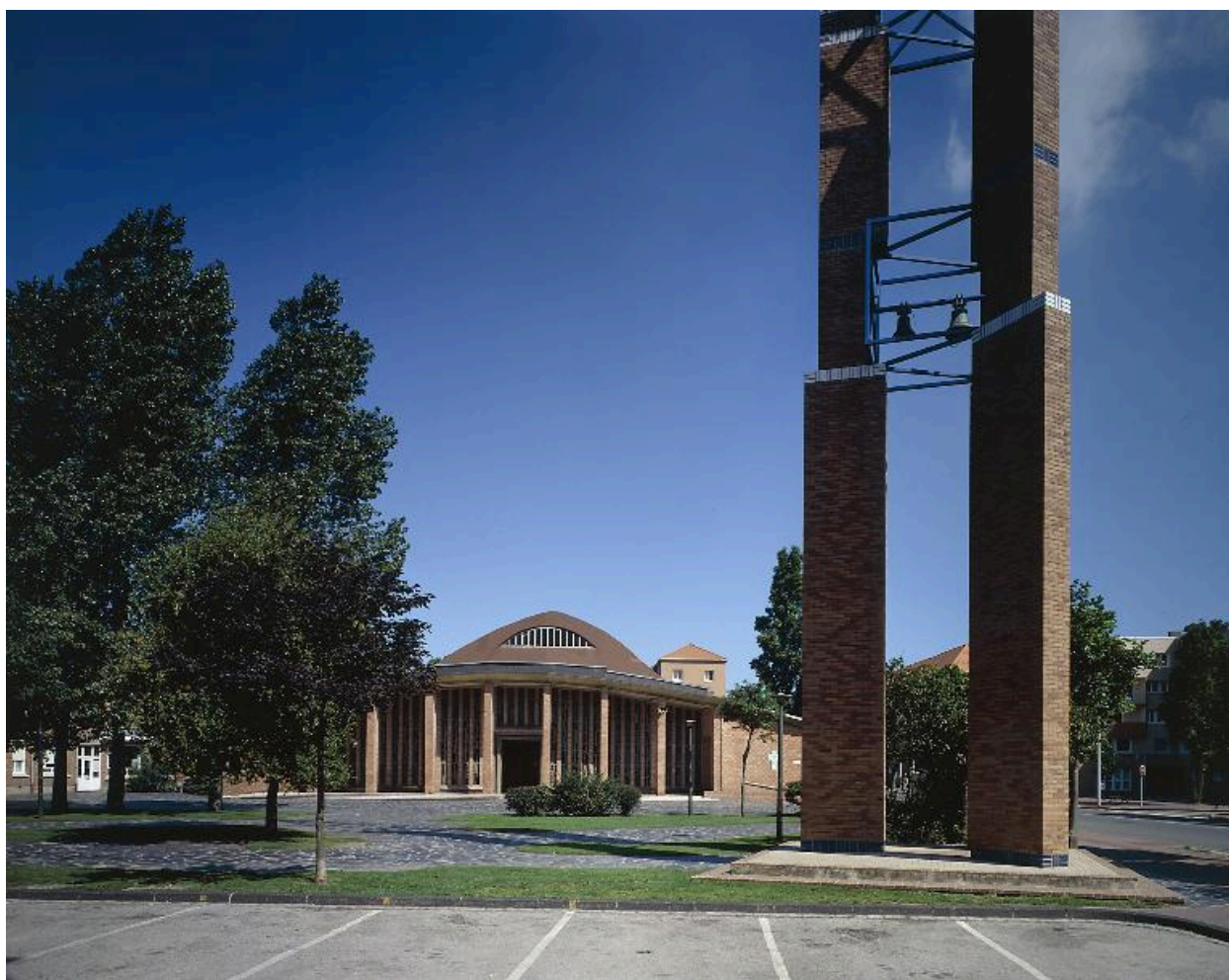
Vue de la façade principale et du clocher.
