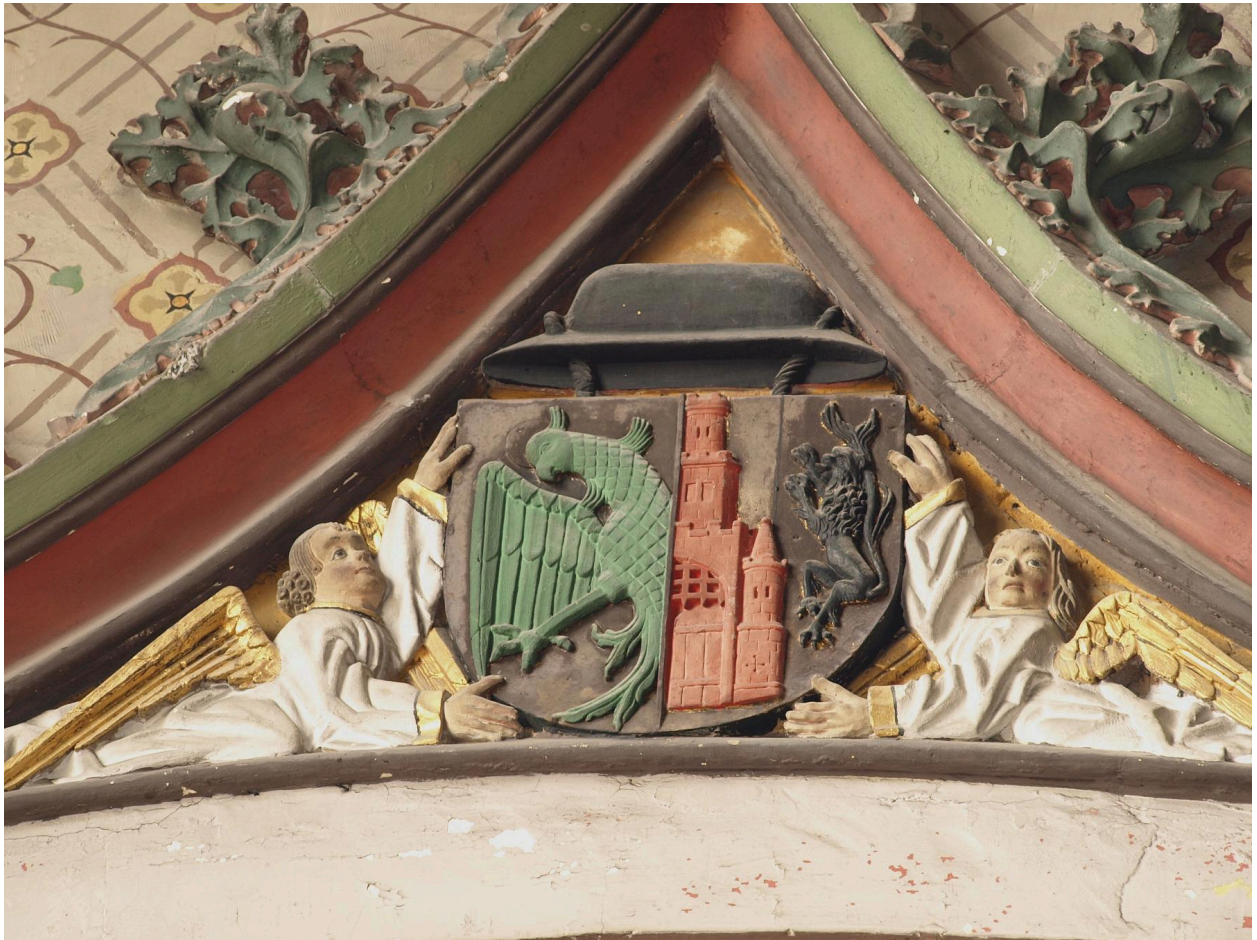
Vue de détail, armoiries.
