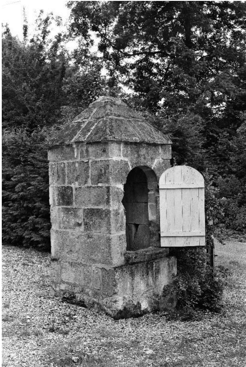
Vue générale du puits.
