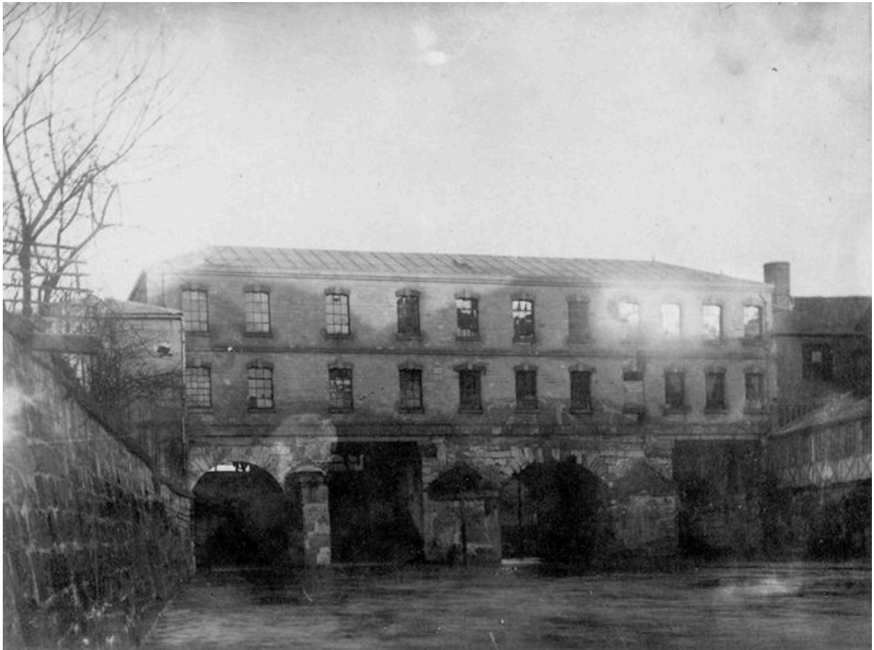
Le moulin de la faïencerie construit sur le petit bras de l'Oise, vers 1895 (musée Gallé-Juillet, Creil).
