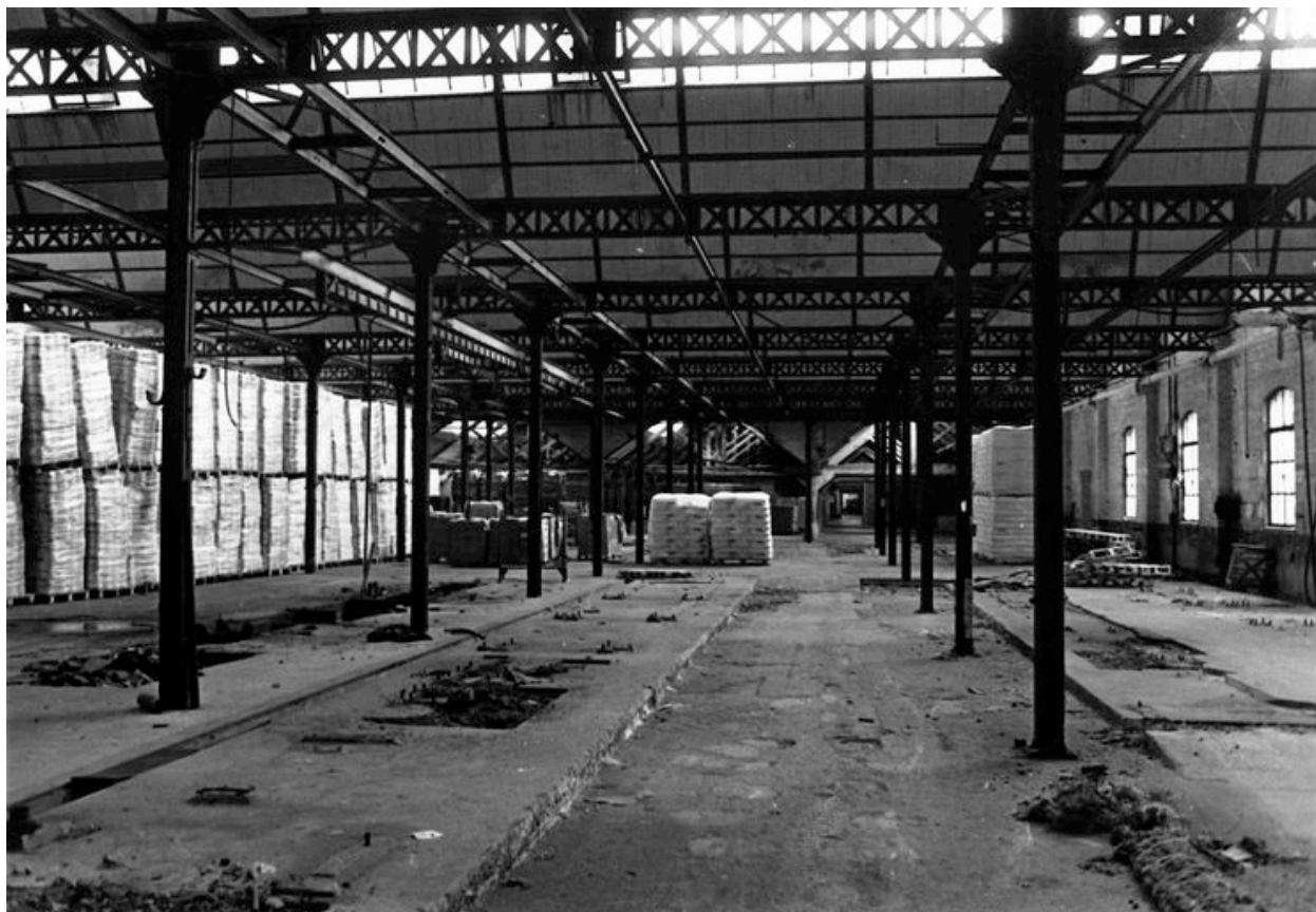
Atelier de ficellerie (fibres naturelles), en 1983 : vue intérieure (Ecomusée du Beauvaisis).
