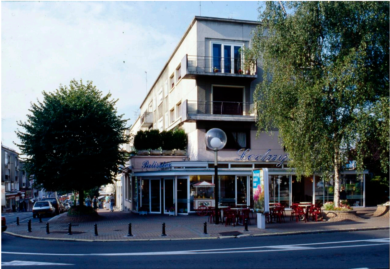
Vue de l'élévation Nord de l'immeuble prise depuis la place des Nations.
