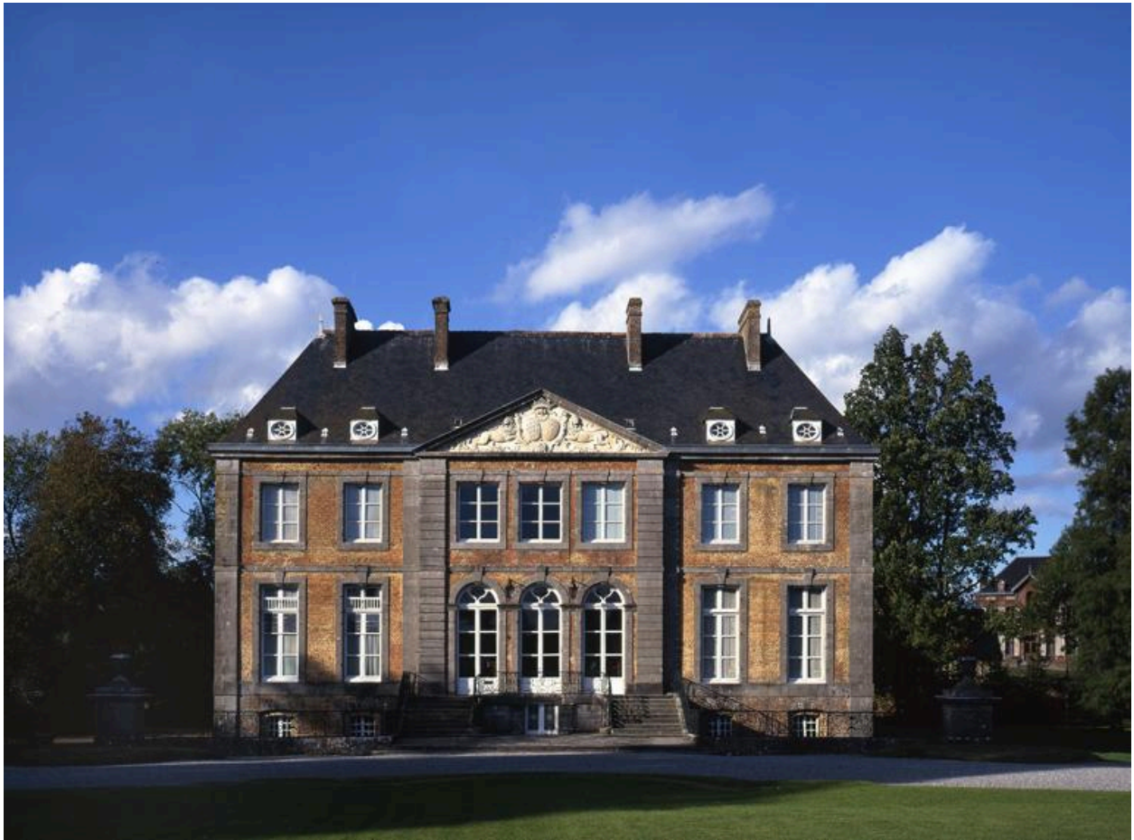
Le logis, vue depuis la cour d'honneur.
