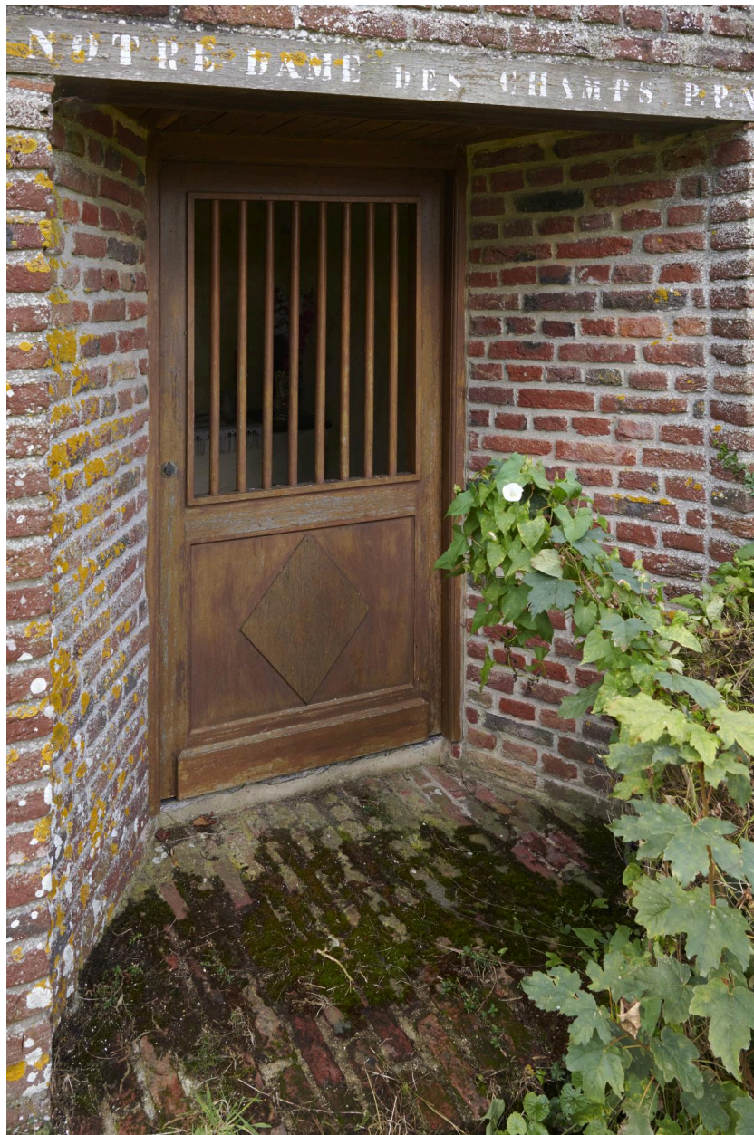
Détail de l'entrée et de la porte.
