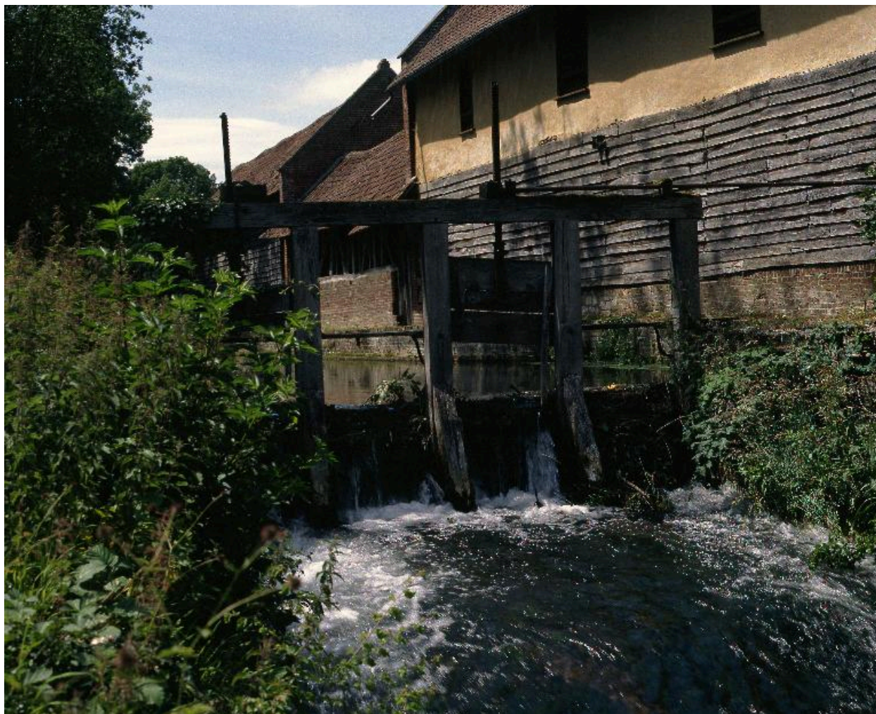
Vue du déversoir.
