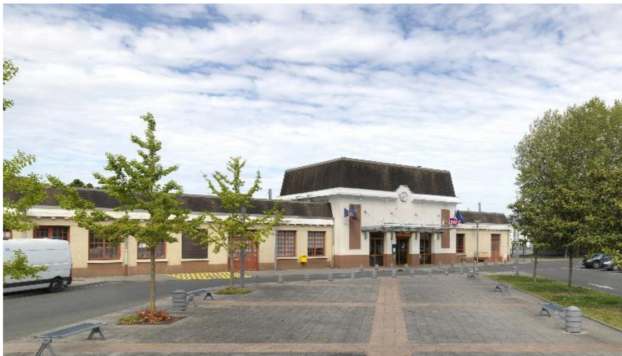
Vue générale, façade principale.
