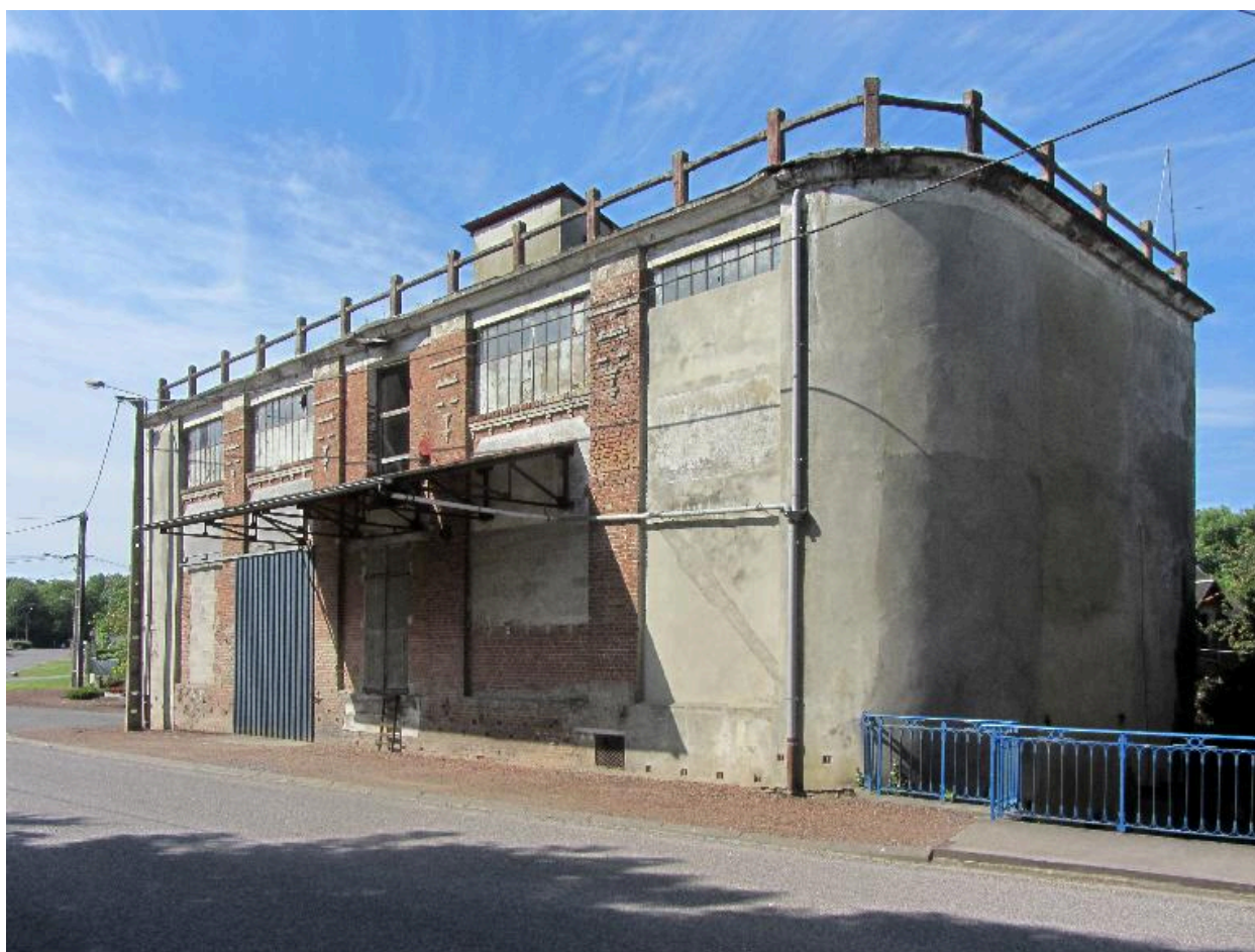
Vue d'ensemble sur rue et du pignon sur la rivière.
