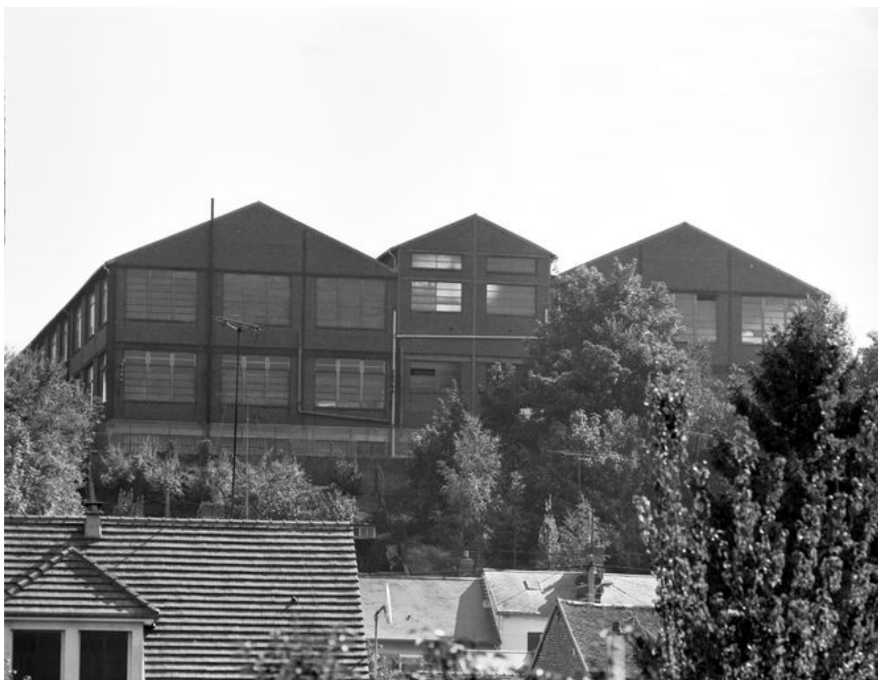
Façade ouest de l'usine.
