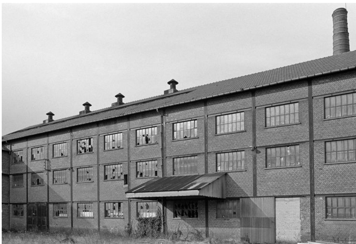
Atelier de fabrication, flanc sud.
