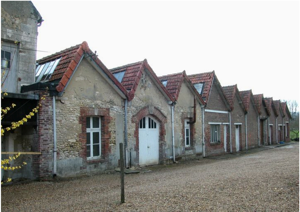
Vue d'ensemble de la façade nord-est des ateliers de brosserie.
