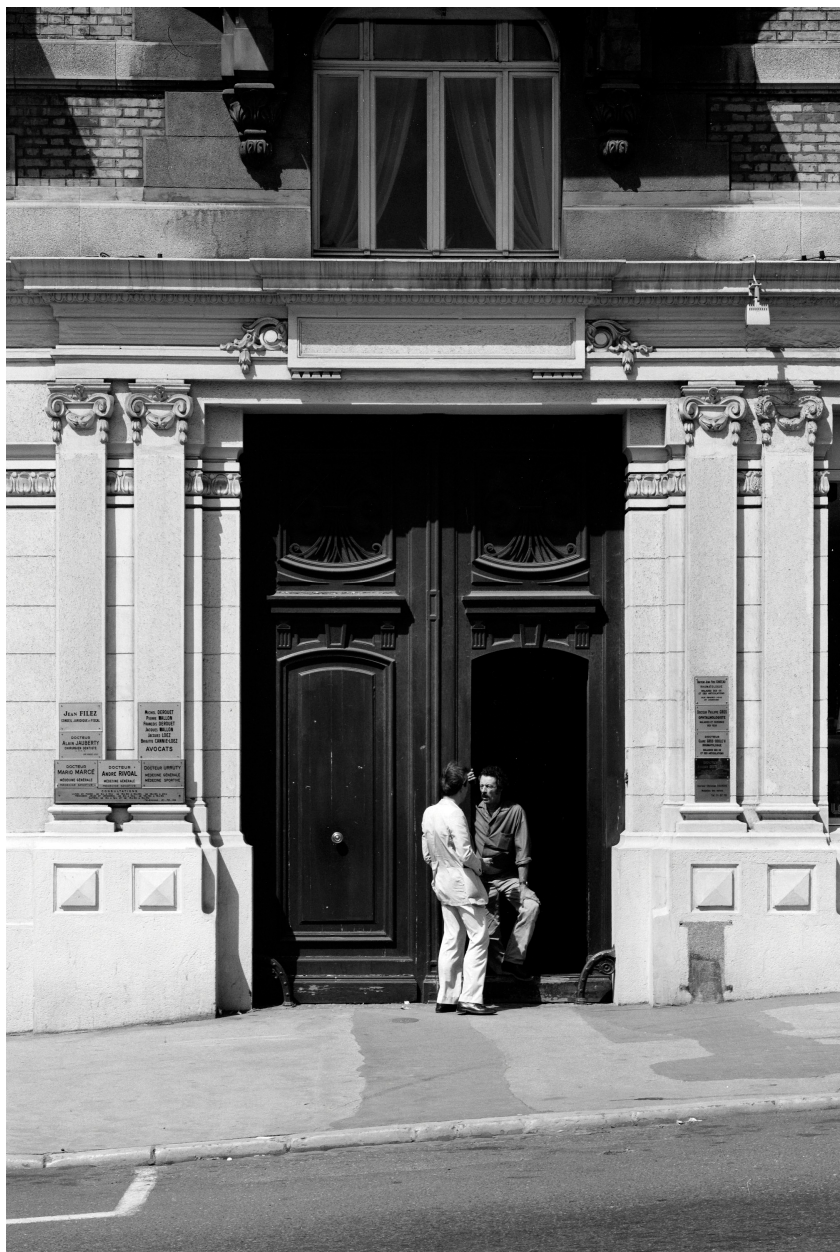
Façade sur voie, portail d'entrée.
