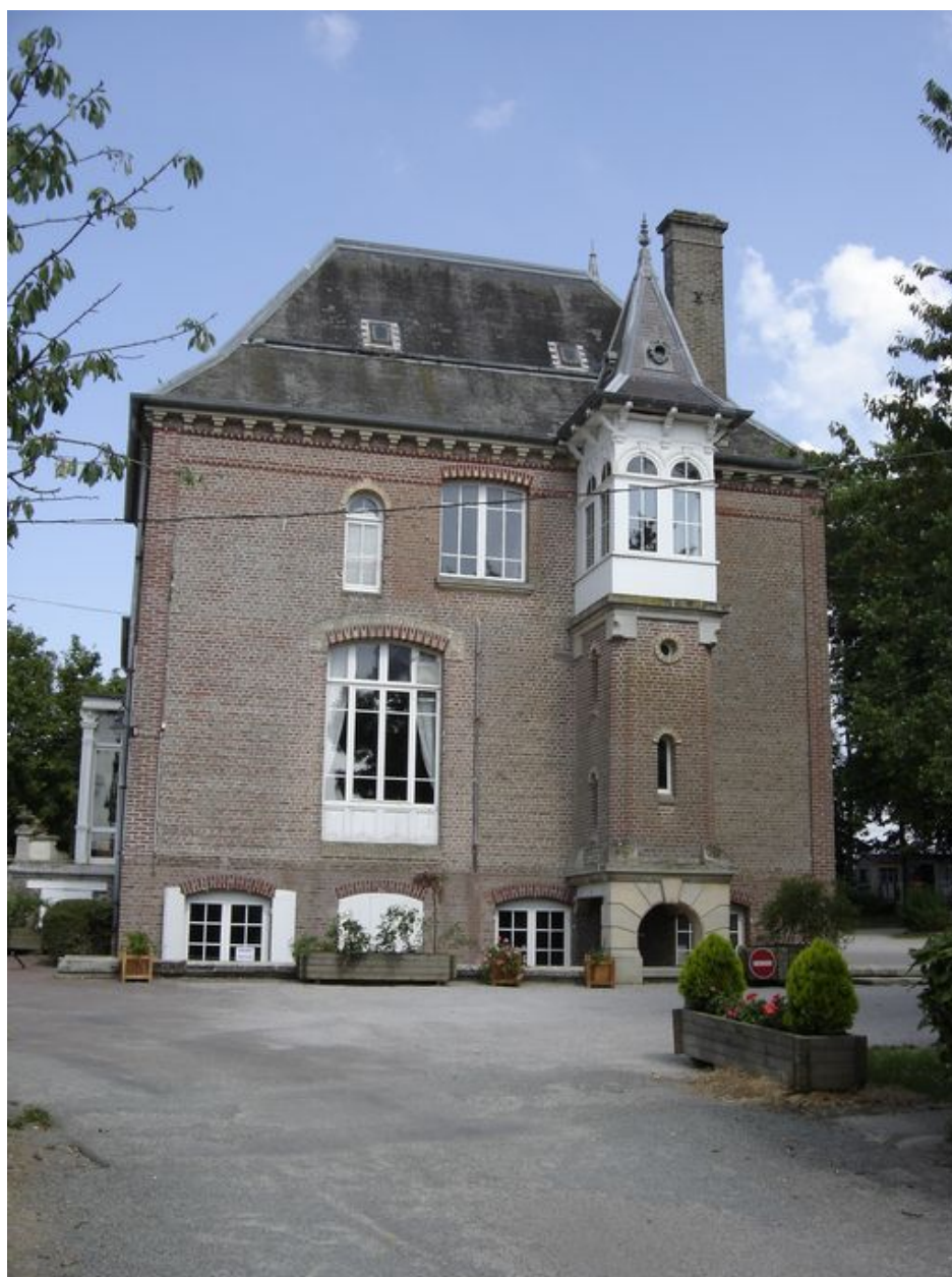
Vue latérale ouest.
